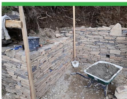
Saint-Martin de Lansuscle - Construction d'un muret de soutènement, avec habillage en schiste, du pays, pour le futur emplacement du P.R.C.S «NOGARET» qui viendra en remplacement d'une «Cabine Haute».
